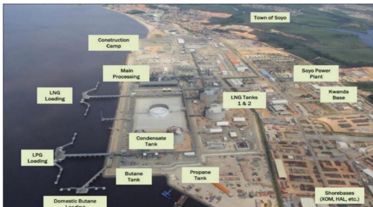
Figura 4 - Fábrica Angola LNG. Fonte: ALNG
