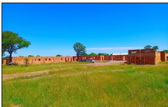
Construção do CERPA – Gambos – Huíla
